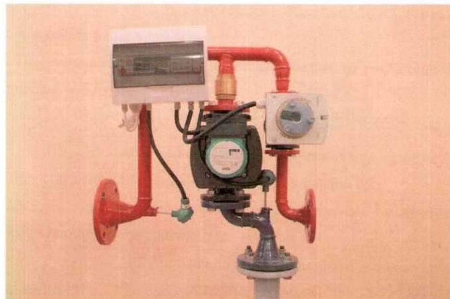
Рисунок 2.1 – Смесительный узел погодного регулирования.
